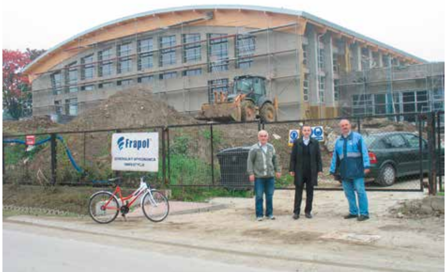
Radni z Piasków Wielkich niemal codziennie odwiedzają plac budowy, obserwując błyskawicznie postępujące prace. Na zdjęciu: Jerzy Wołak (z lewej) i Tadeusz Zgud (z prawej) przedstawiają postęp prac Krzysztofowi Sułowskiemu, Przewodniczącemu Rady i Zarządu Dzielnicy XI. Wykonawca deklaruje, że zakończy prace budowlane za kilka tygodni.
