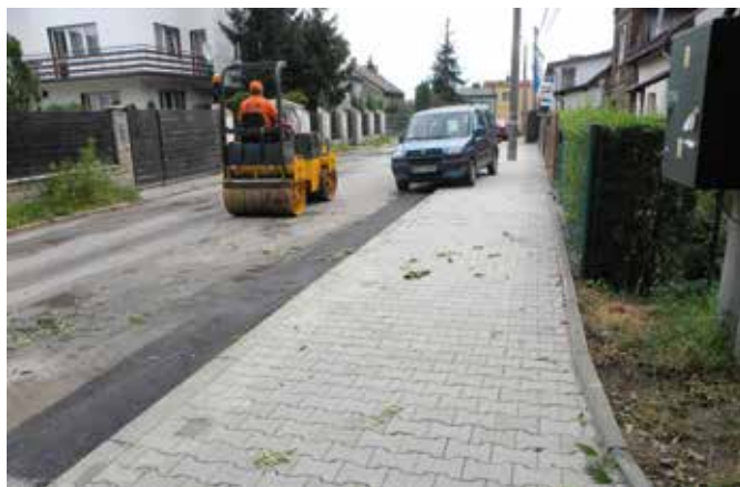
Remont ulicy Gromady Grudziąż
