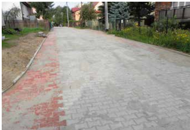
Nowa nawierzchnia ulicy Trawniki
