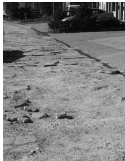
Do walki o remont ul. Nowosądeckiej mogą się też przyłączyć piesi. Tak wygląda chodnik przy budynkach mieszkalno-usługowych.
