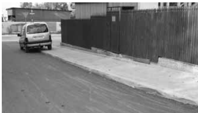
Podczas remontu ulicy Andrychowskiej okazało się, że na pewnym odcinku nie ma podbudowy. Trzeba było ją uzupełnić, wyrównać poziom jezdni i na koniec położyć asfalt
