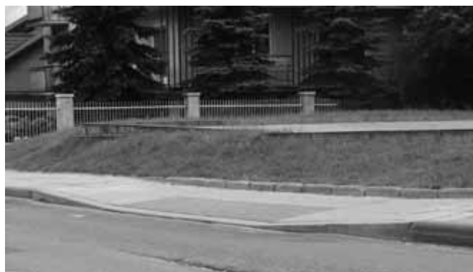
Po obu stronach ul. Łużyckiej obniżono krawężnik, by ułatwić komunikację między osiedlami Piaski Nowe i Kurdwanów osobom starszym, matkom z wózkami
